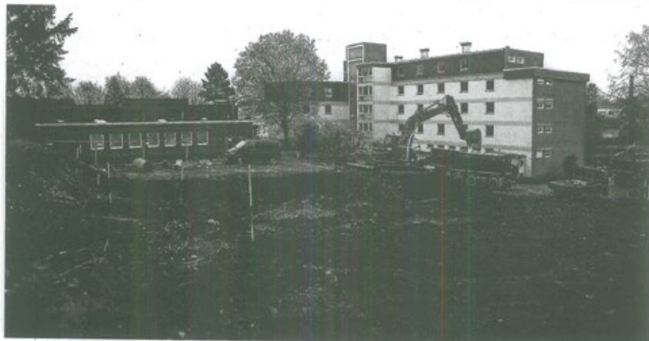
20 Monate Bauzeit hat Bauherr Rolf Körschgen eingeplant. Dann soll im Sommer 2015 die Einweihung gefeiert werden. Der Bagger hat inzwischen damit begonnen, die Baugrube auszuheben. B&P-Foto, J&D
